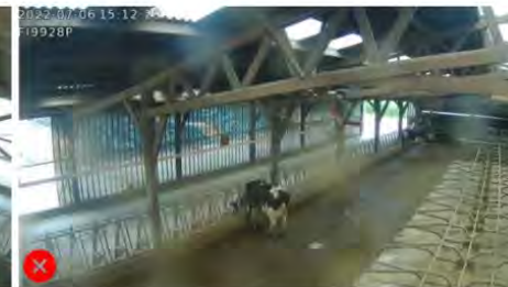
Tôle perforée encore présente (peu d'entrées d'air) + ventilation dynamique = pas de fréquentation des vaches
